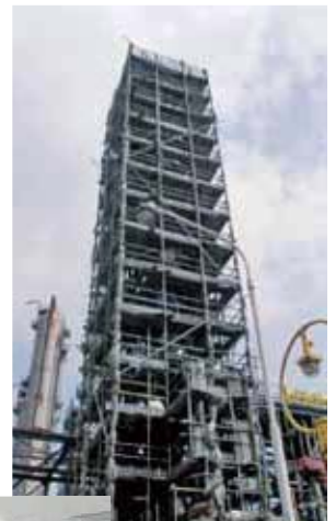
▲タワーの外面腐食検査の様子
